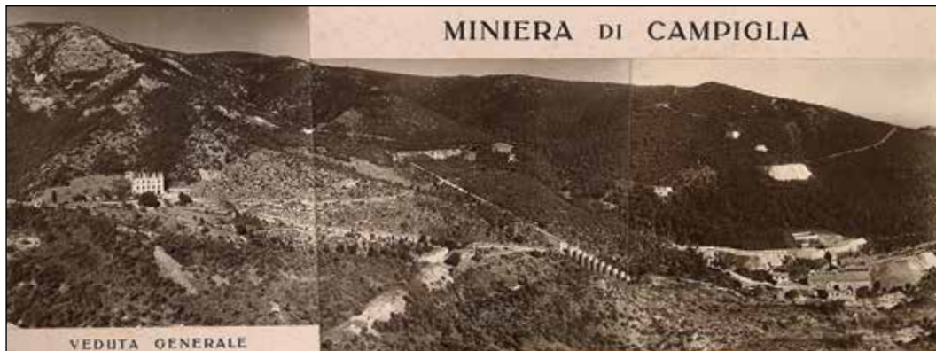
La Valle dei Lanzi, dal Palazzo Gowett fino alle laverie, in un'immagine degli anni '50. Al centro si notano i ruderi del piano inclinato, costruito dagli Inglesi all'inizio del '900, che collegava il Livello 2 della Miniera dei Lanzi con la ferrovia mineraria. Archivio Parco Archeominerario di San Silvestro.
